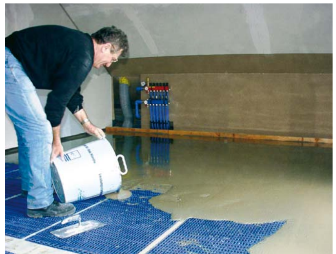
Heiz-/Kühlmatte „FOLIMAT“ direkt unter dem Bodenbelag
