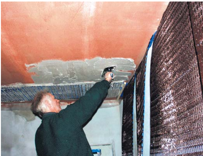
Heiz-/Kühlmatte „FOLIMAT“ in Wand- oder Deckenflächen
