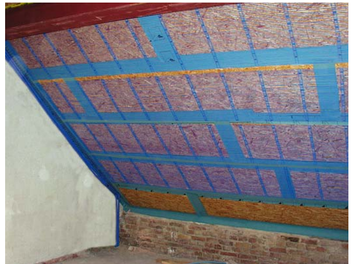
Heiz-/Kühlmatte „OPTIMAT“ in Wand- und Deckenflächen
