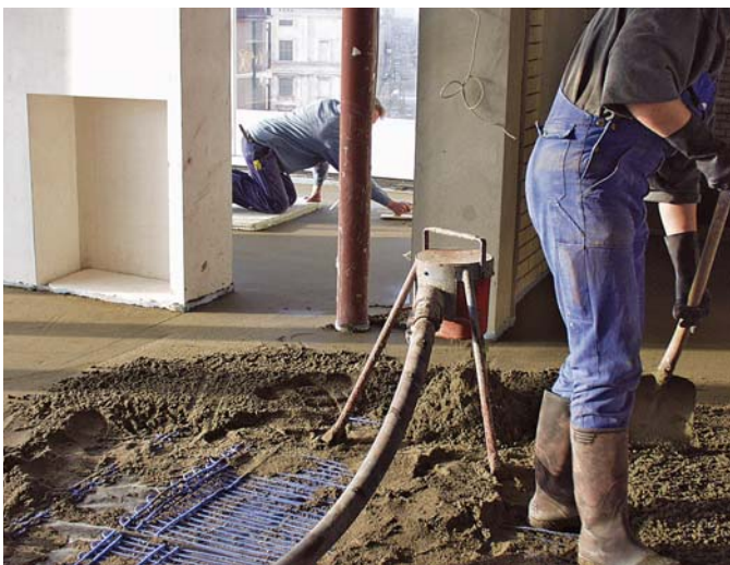
Heiz-/Kühlmatte „OPTIMAT“ im Estrich
