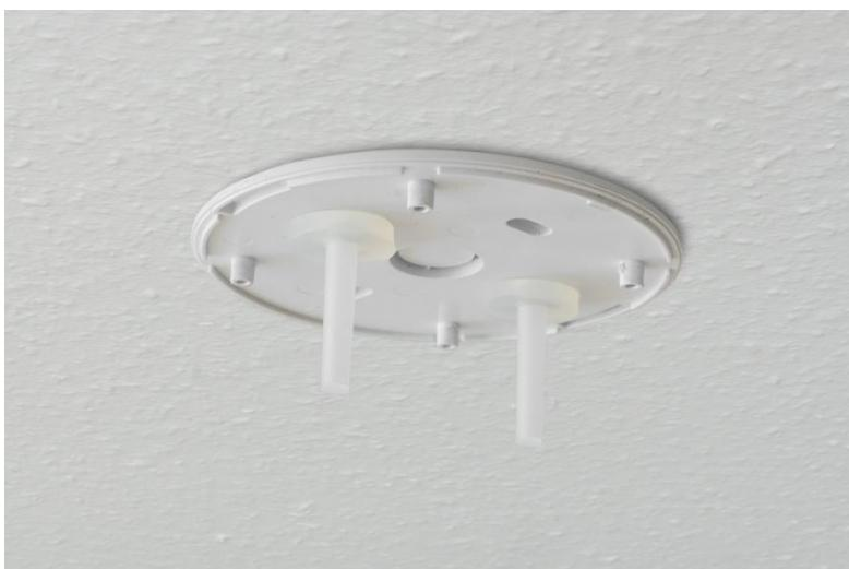
Zur Fixierung der Grundplatte die zwei Silikonringe auf die „Fühlerröhrchen“ stecken und bis ganz nach oben schieben. Die Grundplatte sollte nun fest an der Decke hängen.
